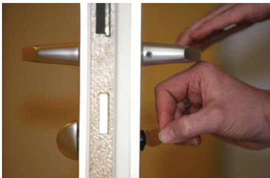
Die WC-Garnitur kann im Notfall mit einem Geldstück geöffnet werden.
